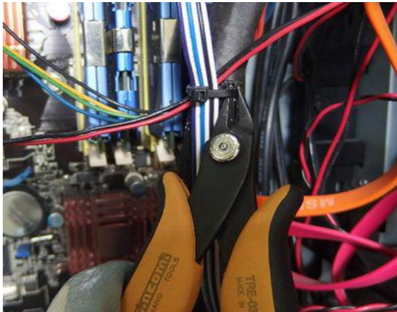
Ελευθέρωση δεματικού (Cable Tie) καλωδίων
